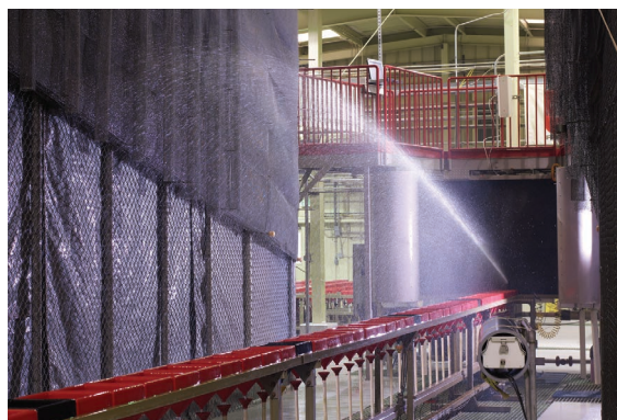
Weitreichende Tests für die Effizienz der T5 Düsen wurden mit SPACE-Berechnungen ausgeführt
